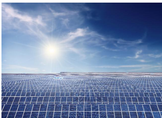
1. 光伏储能逆变器
